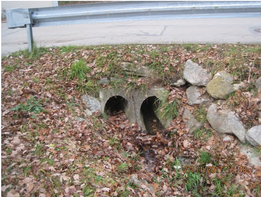
Abbildung 2: Straßenunterführung des Grabens I
